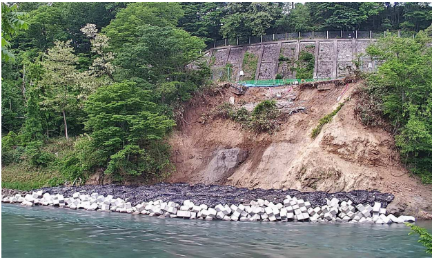
根固めブロック設置状況
