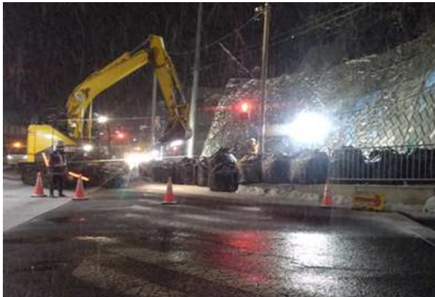
大型土のう設置状況
