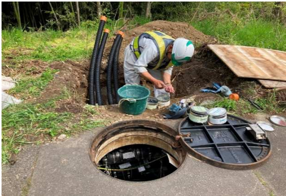
仮設管路接続状況
