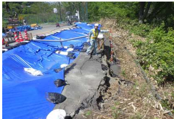
崩落部調査実施状況
