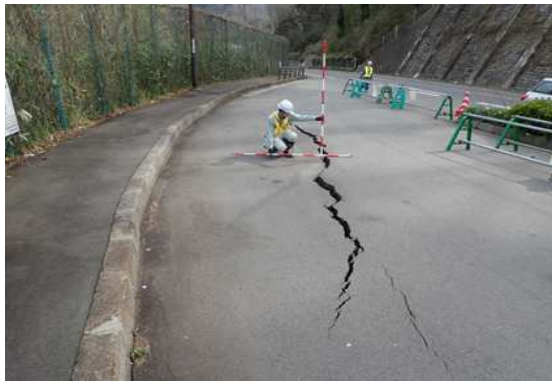
路面亀裂調査実施状況
