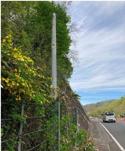
自営柱建柱状況 (道路横断箇所)
