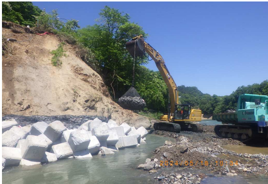
根固めブロック設置状況
