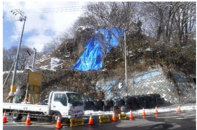
ブルーシート設置状況
