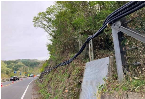
仮設管路敷設状況
