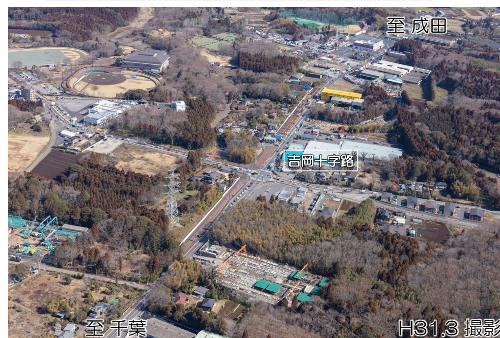
■写真① 吉岡十字路交差点付近
