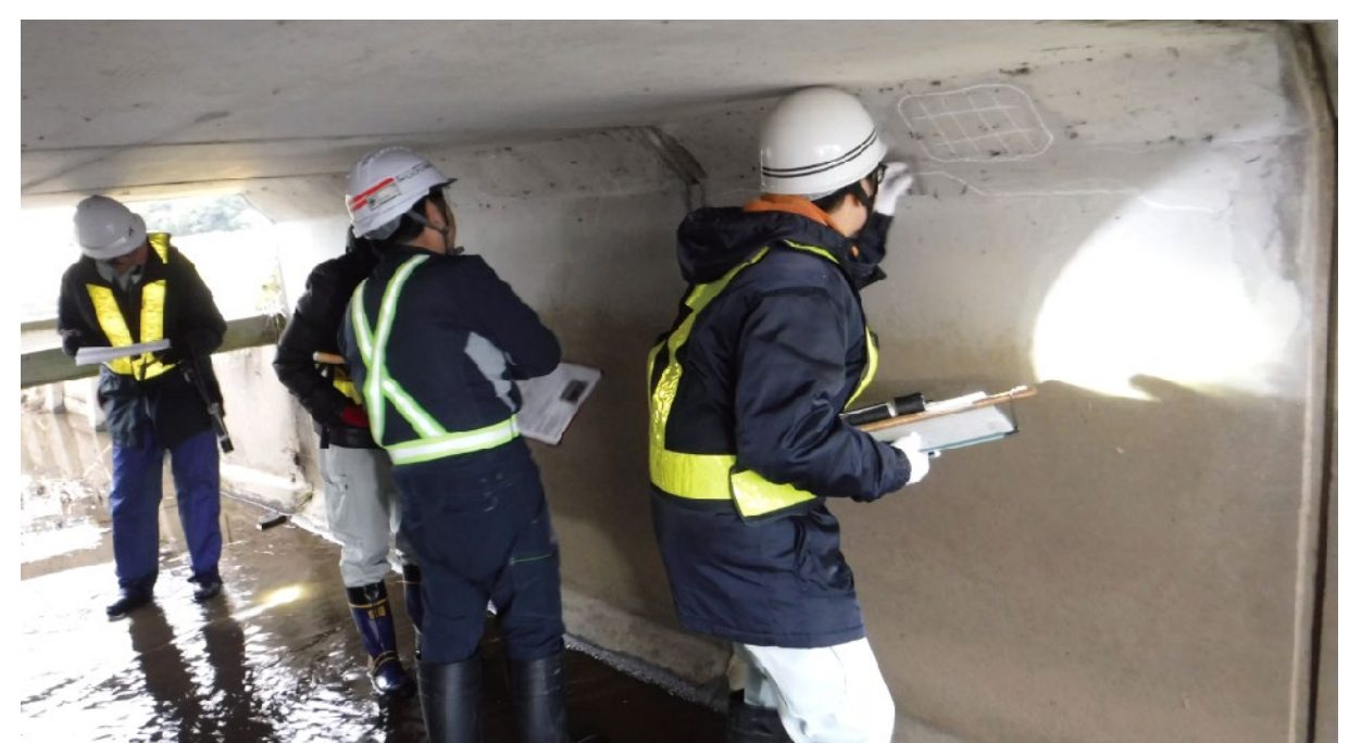
橋梁点検実習（近接目視点検の状況）
