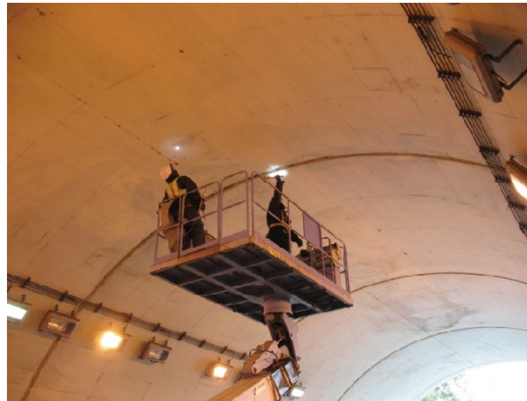
国道127号勝岩トンネル（南房総市二部）
