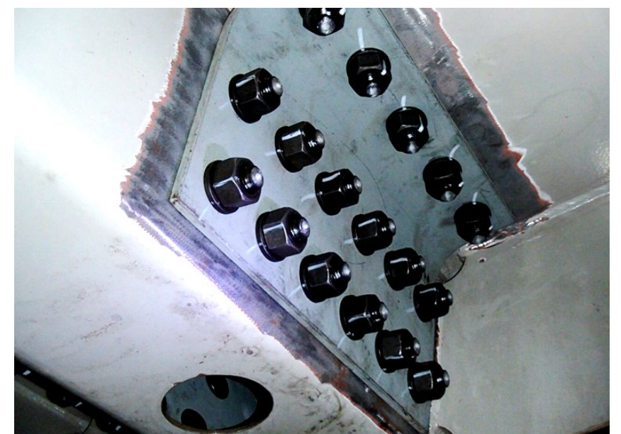
③損傷（亀裂）箇所のあて板補修を実施。
