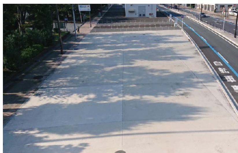
【通常時】 千葉市役所前上部空間
