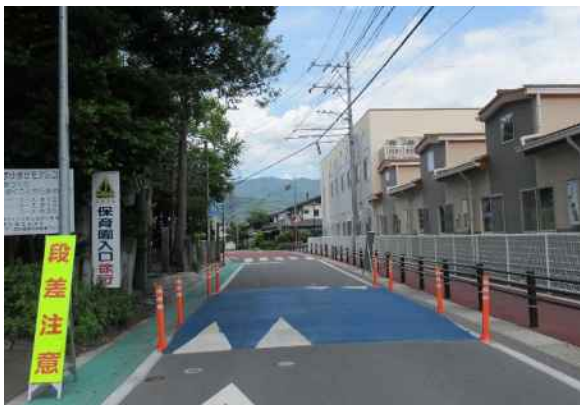
②イルフ西堀保育園前 ハンプ設置状況
