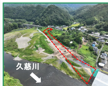
工事箇所の全景（下流から）
