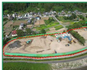
ストックヤードの全景（上流部）
