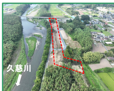
工事箇所の全景（下流から）
