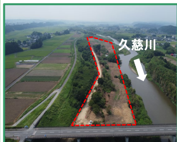
工事箇所の全景（下流から）
