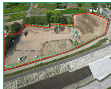
ストックヤードの全景（下流部）
