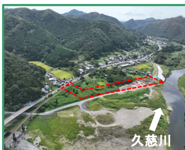
工事箇所の全景（上流から）
