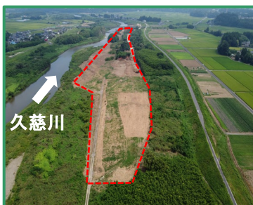
工事箇所の全景（上流から）
