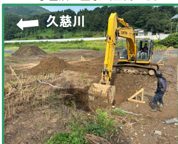
樋管本体の床掘りを行っています
