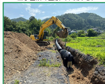
仮水路の設置を行っています
