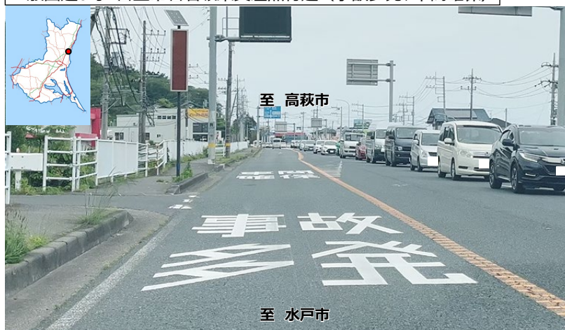
一般国道6号 日立市石名坂東交差点付近 (事故多発、車間確保)
