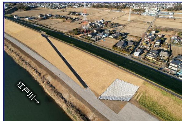
R5江戸川左岸今上地先中地区堤防整備工事 【流山市内の堤防整備工事】
