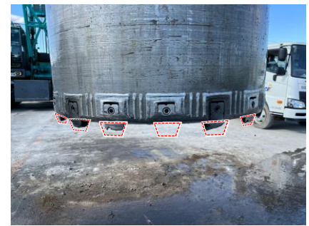
ケーシングビットの摩耗状況
