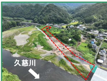
工事箇所の全景（下流から）
