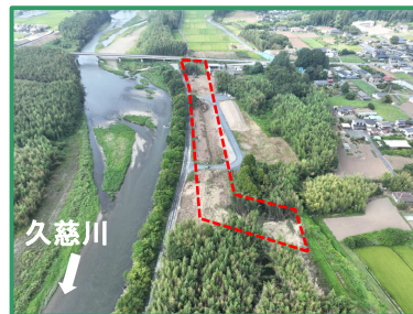
工事箇所の全景（下流から）
