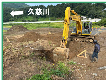
樋管本体の床掘りを行っています
