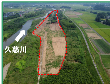
工事箇所の全景（上流から）
