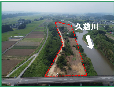
工事箇所の全景（下流から）
