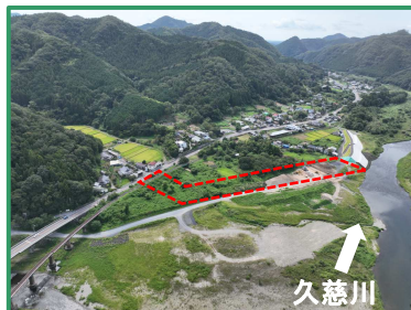
工事箇所の全景（上流から）
