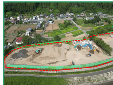
ストックヤードの全景（上流部）
