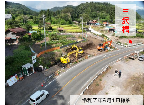
付替道路工 施工状況
