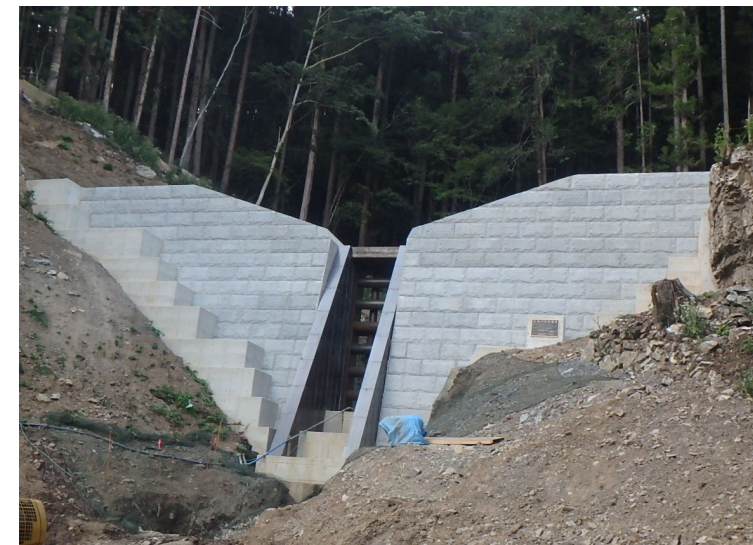
鋼製堰堤本体工
