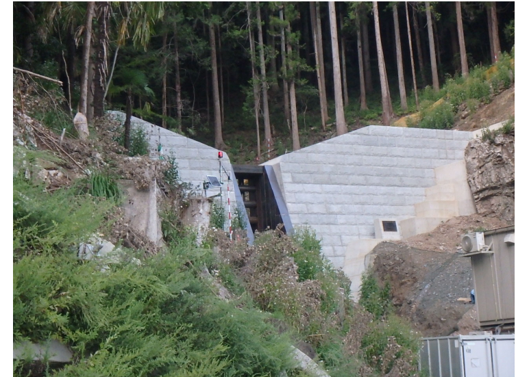
鋼製堰堤本体工
