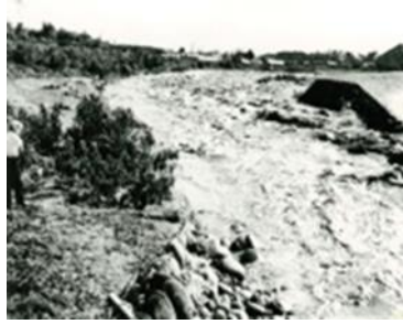
写真 1 笛吹川左岸決壊
