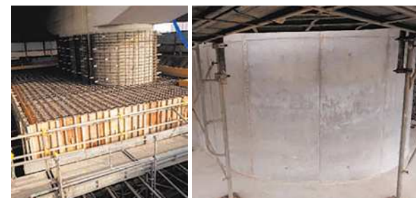
潮郷橋耐震補強工事(橋脚補強)
