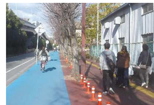
国道298号側道(戸田市内)
