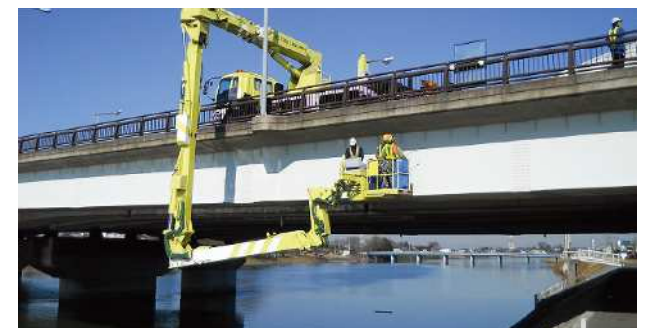
橋梁点検車による点検
