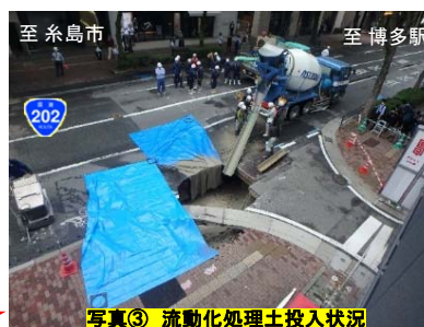
写真③ 流動化処理土投入状況
