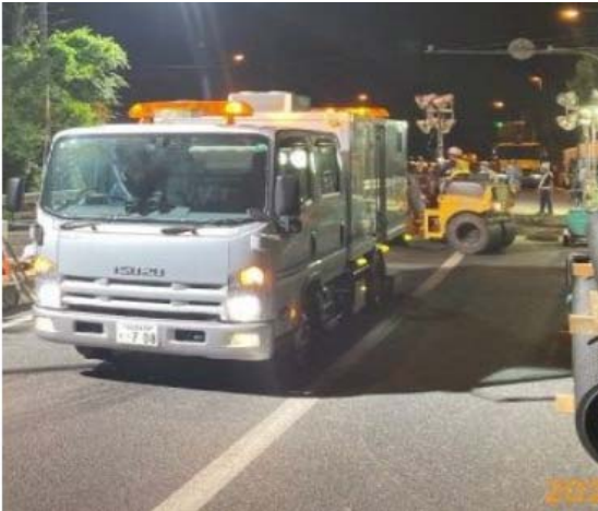
路面下空洞探査車での調査
