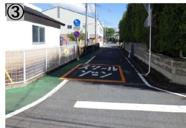
路肩カラー舗装
