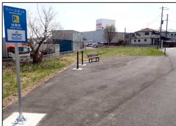
常総衛生組合周辺RS完成 状況(R6年度市整備)
