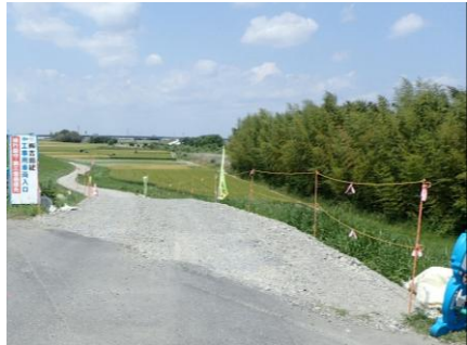
築堤工事で使用した工事用道路の碎石舗装
