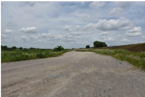
築堤工事で使用した工事用道路の碎石舗装
