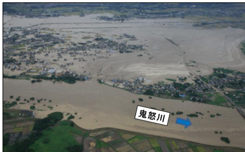
決壊箇所全景
