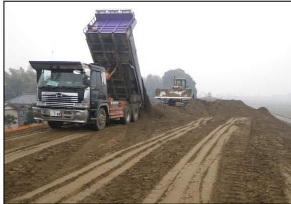
盛土材の搬入状況
