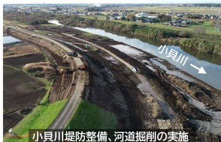
小貝川堤防整備、河道掘削の実施
