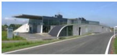
藤代河川防災ステーション
