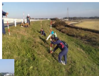
堤防点検の状況
