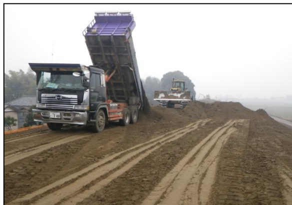
盛土材の搬入状況
