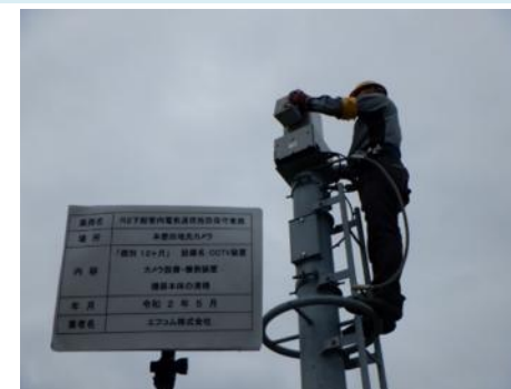
CCTVの点検状況
