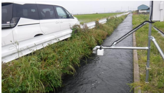
流況調査の状況(農業用水路の観測事例)
