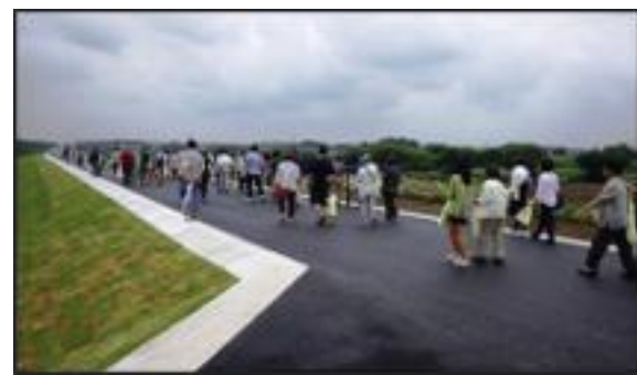
堤防天端の状況
