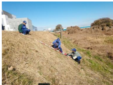
堤防点検の状況
