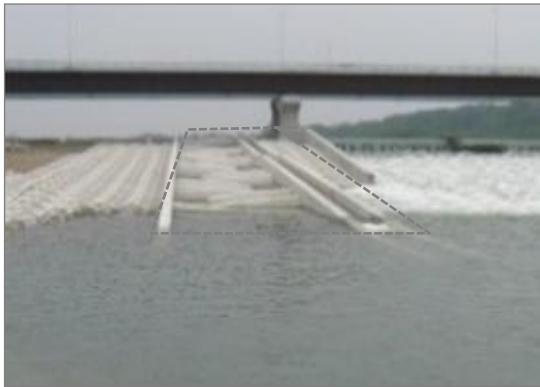
勝瓜頭首工(遡上環境改善)
