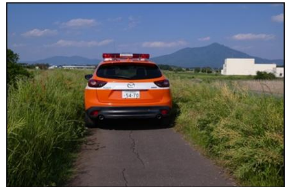
堤防天端の雑草繁茂の状況
