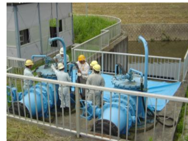
機械設備の点検
