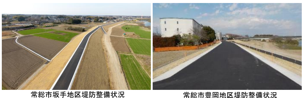
常総市坂手地区堤防整備状況
