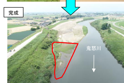
河道整備工事の事例(R3.6.30完成)
