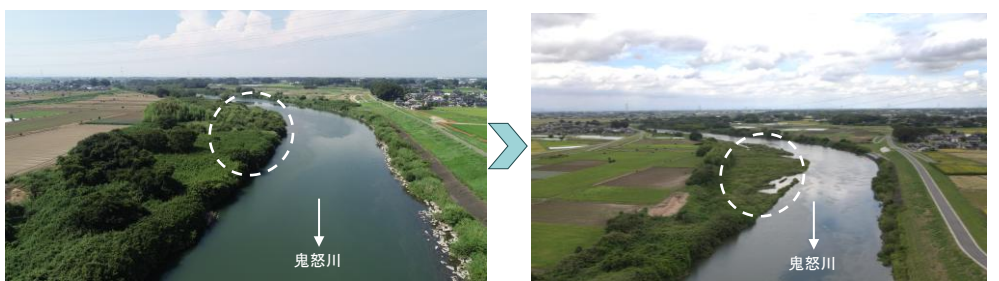
掘削工事実施前
