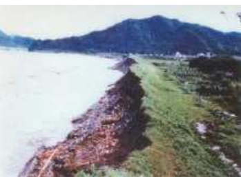
東海道本線鉄橋の流失 富士川町駅前通り地区の浸水 身延町波木井地先の堤防洗掘
