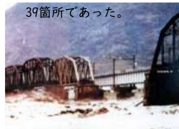
東海道本線鉄橋の流失 富士川町駅前通り地区の浸水 身延町波木井地先の堤防洗掘
