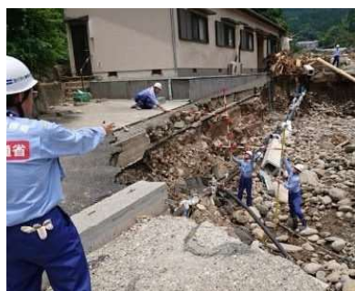
河川被害状況の調査
