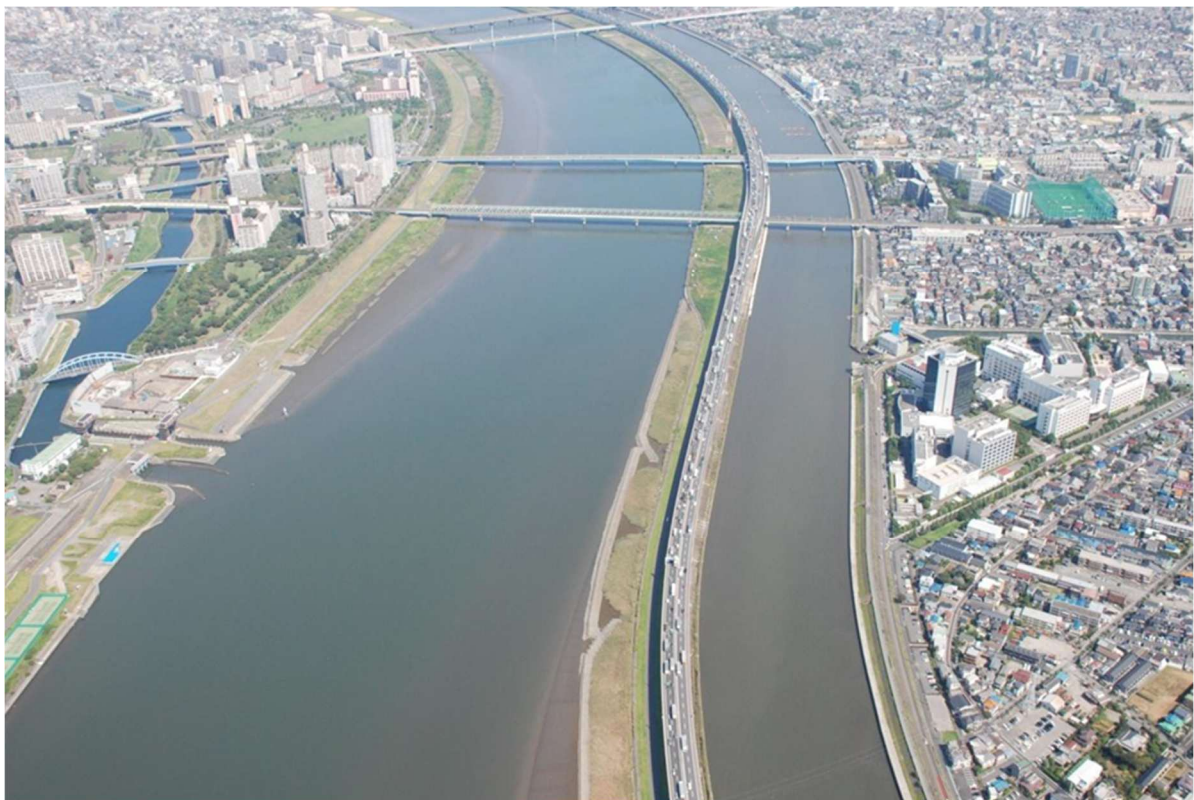
小松川ブロック付近の荒川（2.5km～5.0km）
