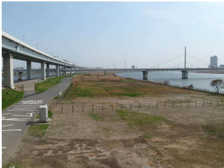
中堤（小松川橋付近）
