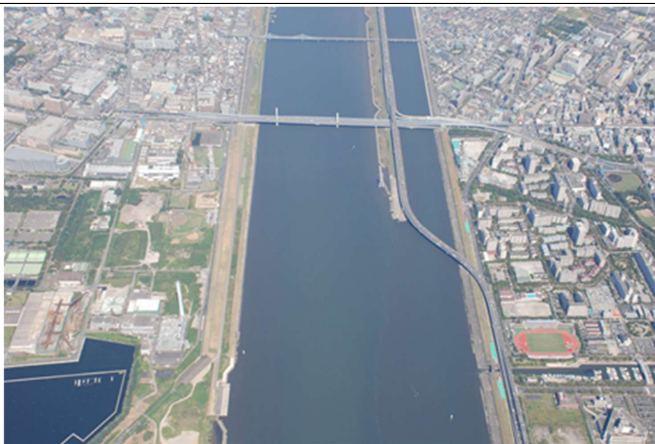
新砂ブロック付近の荒川（0km 付近）
