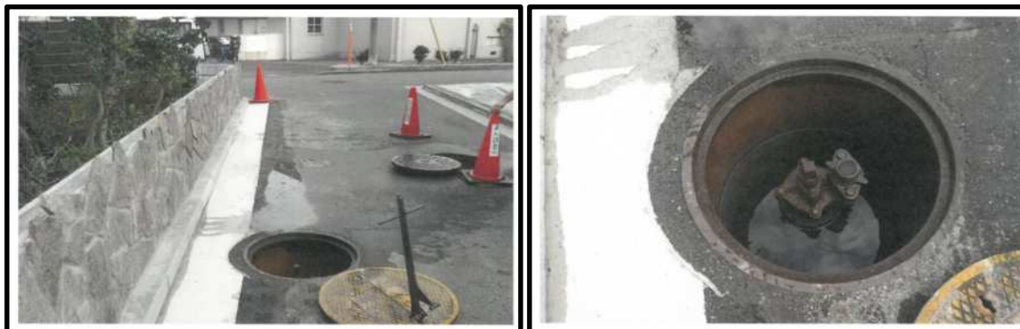
漏水調査（神奈川県横浜市）
