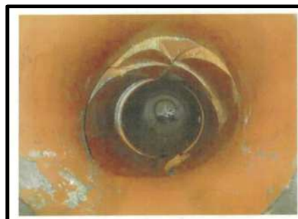
管路調査（神奈川県横浜市）
