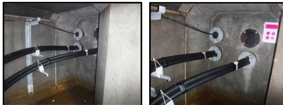
マンホール内部点検
