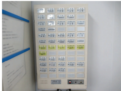
図2 事務庁舎棟（副受信機）
