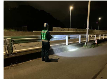
＜徒歩巡回による変状監視（夜間）＞
