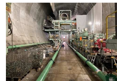
土砂圧送配管敷設状況
