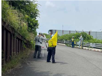
＜地表面変状 計測状況＞
