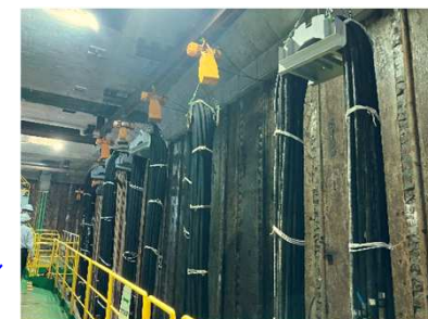
初期掘進用ホース・ケーブル設置状況
