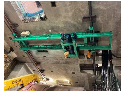
天井クレーン設置状況
