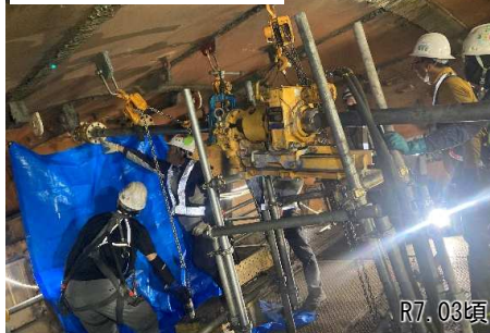
先受け鋼管の打設状況
