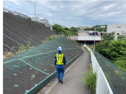
＜徒歩巡回による変状監視（昼間）＞
