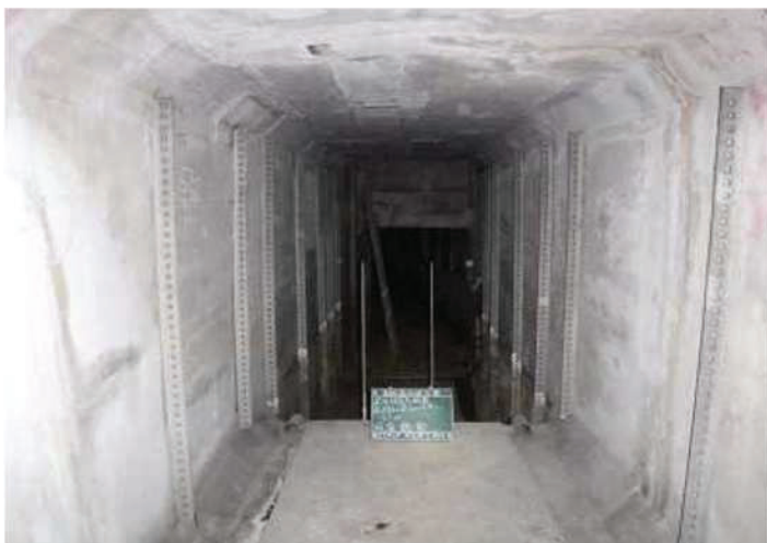
洞道点検状況
