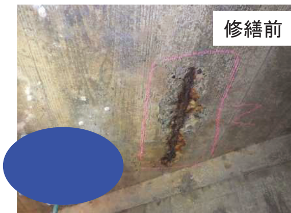
マンホール修繕状況 鉄筋露出部をはつり出し、防錆処理後補修モルタル
