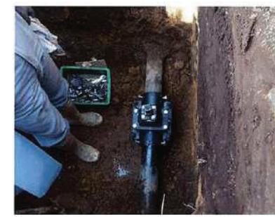
修繕状況(制水弁漏水により取り替え工事)
