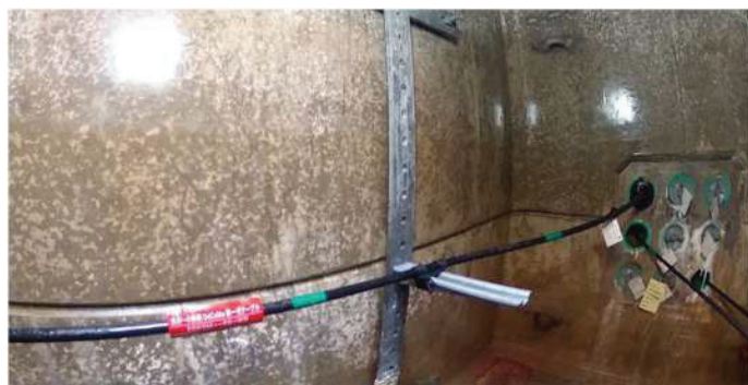
マンホール点検状況
