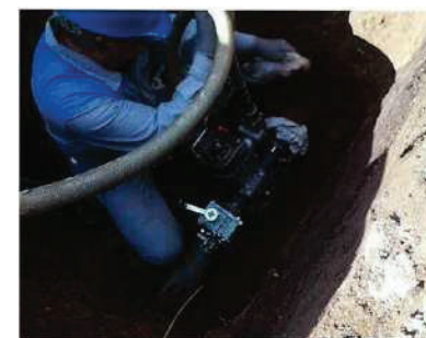
修繕状況(制水弁漏水により取り替え工事)
