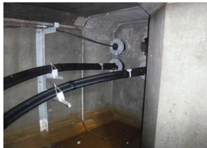
マンホール点検状況
