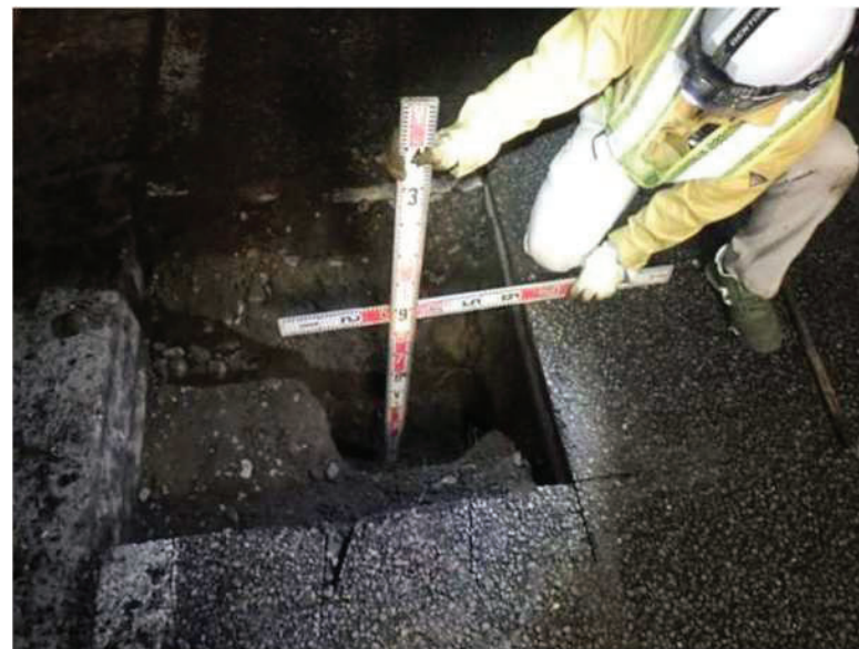
国道50号（群馬県前橋市）
