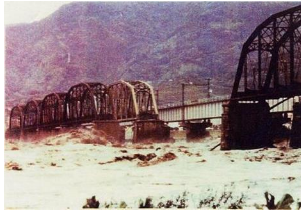
写真 3 昭和 57 年（1982 年）洪水 JR 富士川鉄橋の落橋
