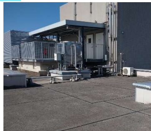
【屋上防水改修前】
