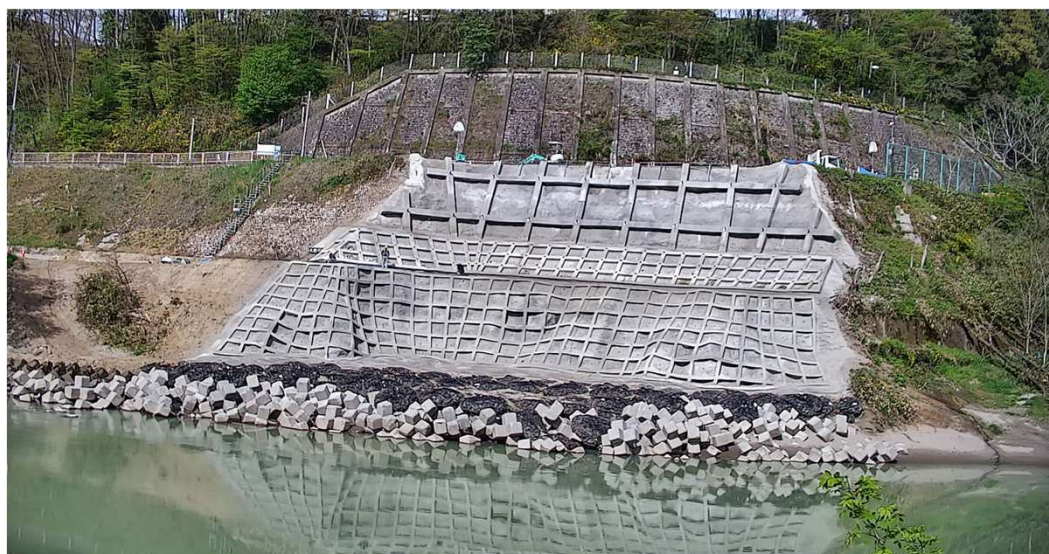
最下段法面:法枠工完了状況
