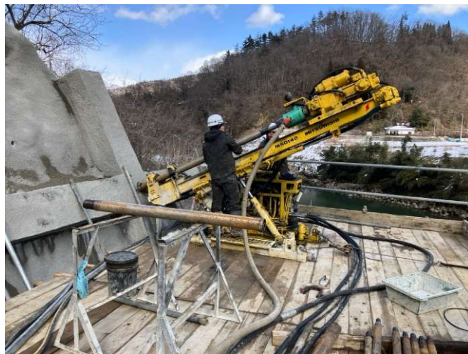
1段目法面:法枠工・アンカー工施工状況
