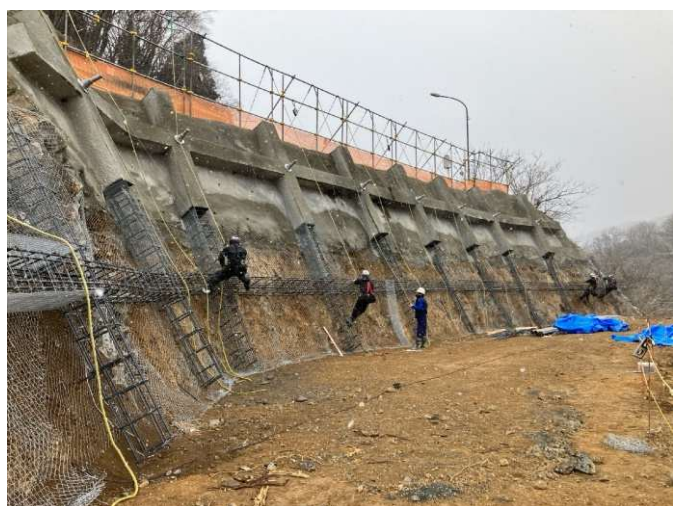
1段目法面:法枠工・アンカー工施工状況
