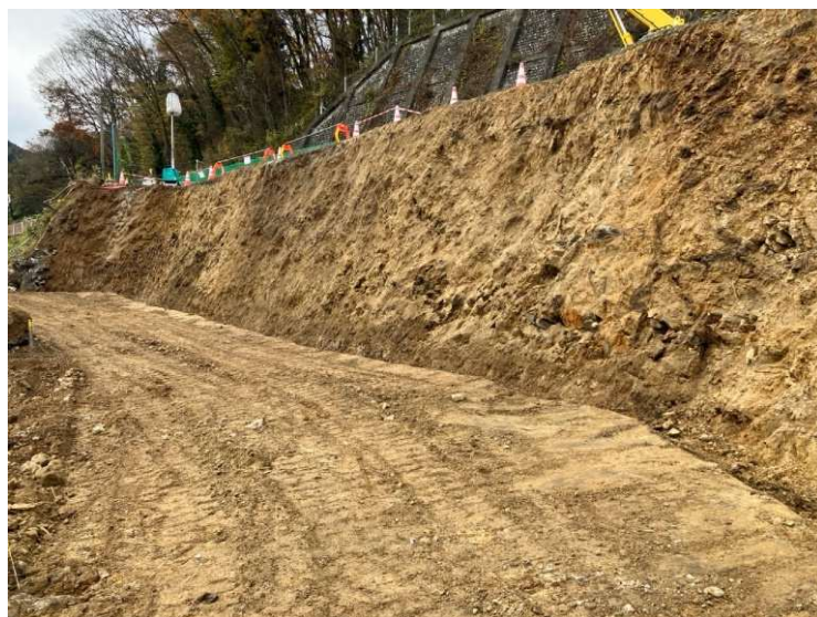
1段目法面掘削完了状況
