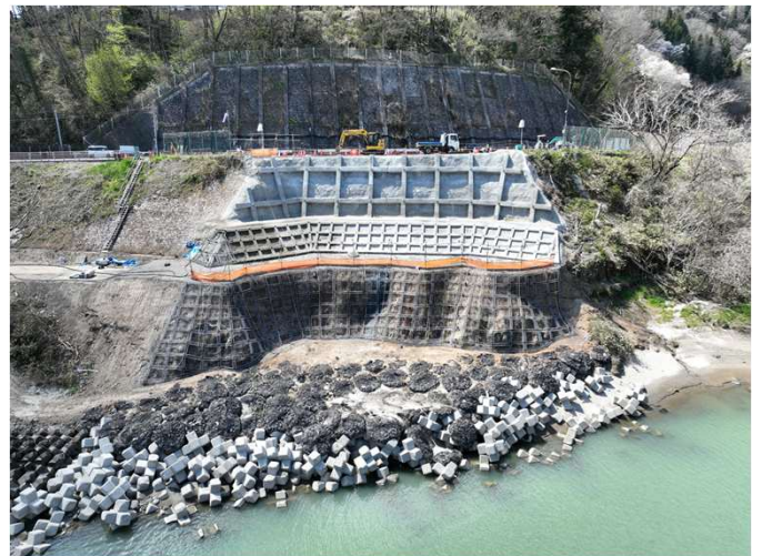
2段目法面:法枠工・鉄筋挿入工完了状況
