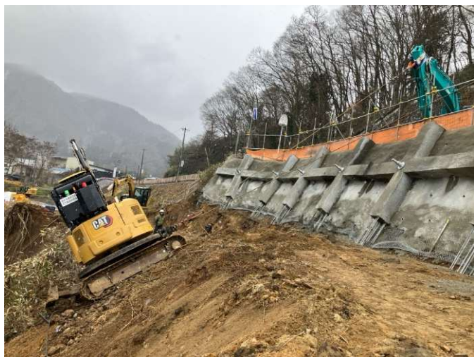
1段目法面:掘削状況
