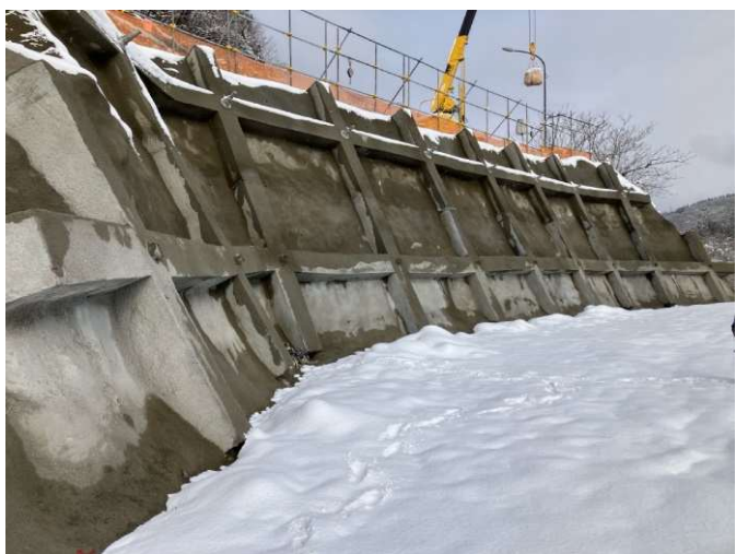
1段目法面:法枠工・アンカー工完了状況
