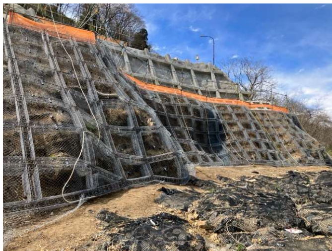
最下段法面:法枠工施工状況
