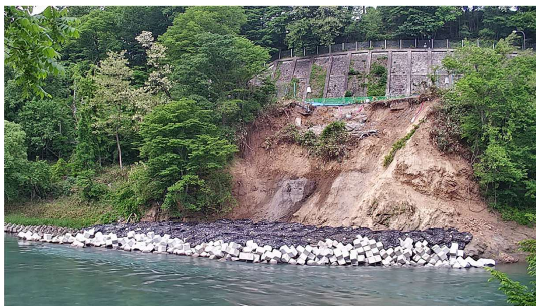
応急対策工(根固めブロック設置)完了状況
