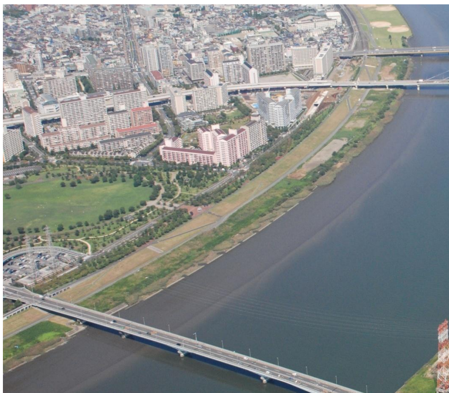
船堀橋～小松川橋付近の護岸（3.5km～5.0km 付近）
