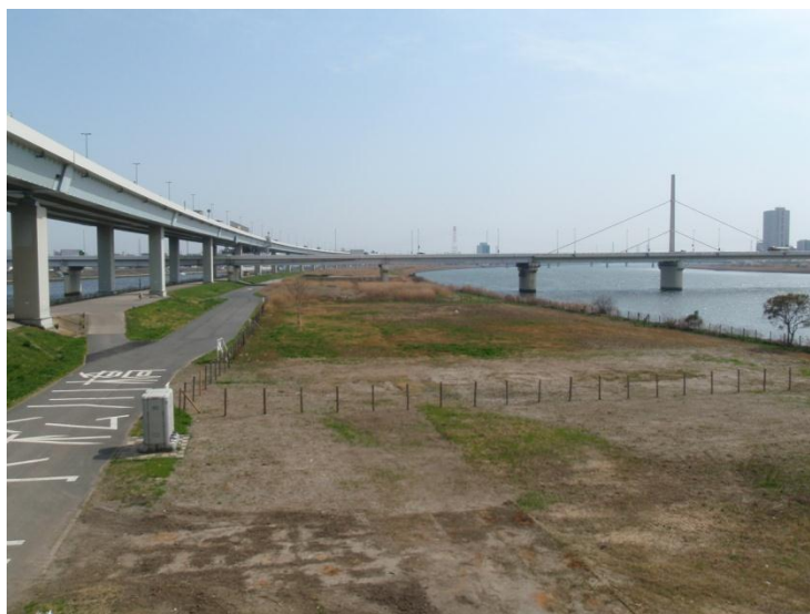
中堤（小松川橋付近）
