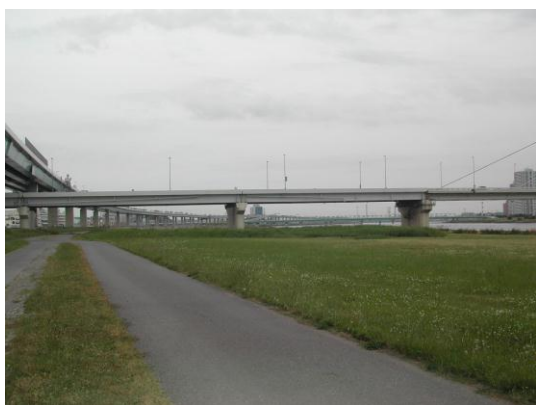
左岸（中堤）ブロック
