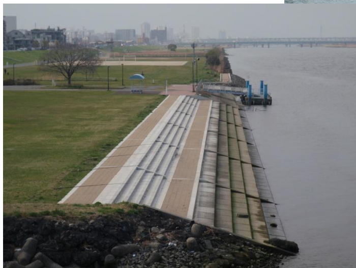
平井水上ステーション・低水護岸
