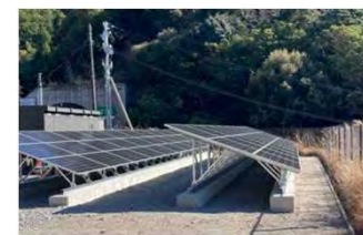
太陽光発電施設の設置
