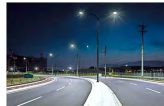
道路照明のLED化
