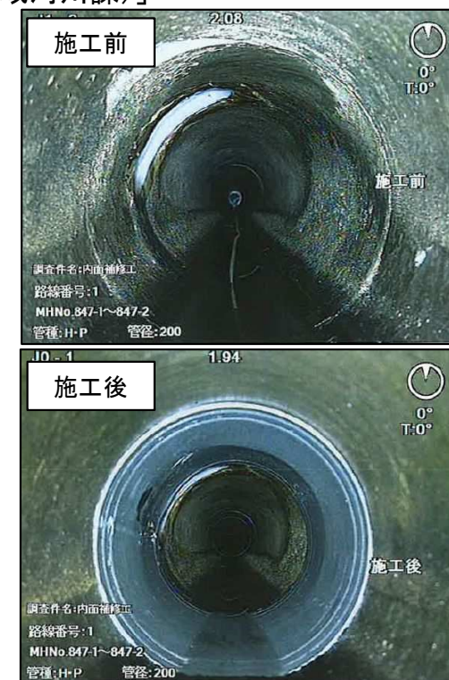
補修事例 内面補修工(茨城県笠間市)
