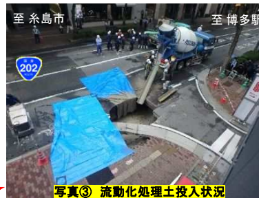
写真③ 流動化処理土投入状況
