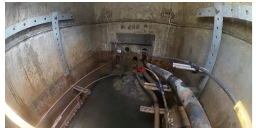
マンホール点検状況（常陸大宮市道） 令和7年度補修予定
