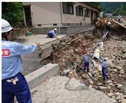
河川被害状況の調査
