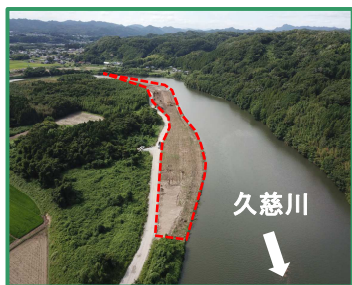
工事箇所の全景（下流から）
