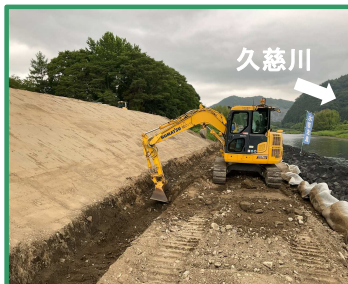
護岸基礎の床掘りを行っています
