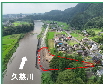
工事箇所の全景（上流から）
