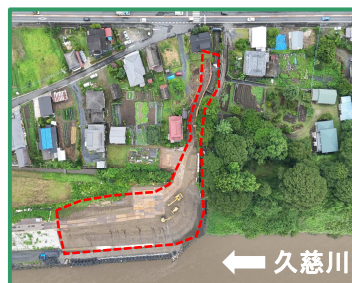
工事箇所の全景（真上から）
