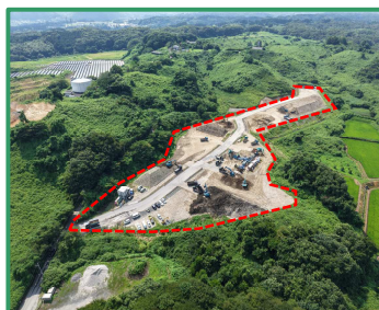
ストックヤードの全景（下流から）
