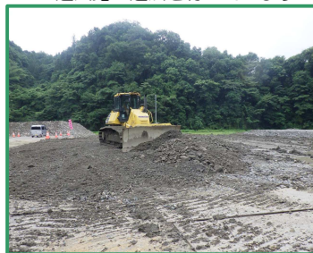
押土作業を行っています
