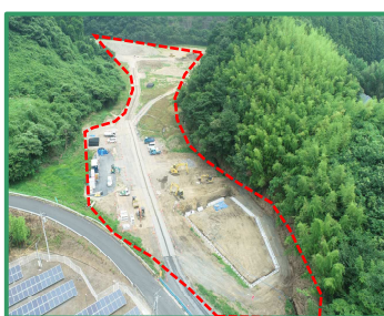
工事箇所の全景（小貫SY）
