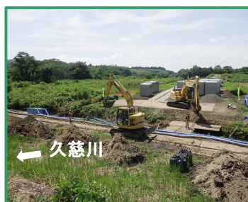
進入路の造成を行っています
