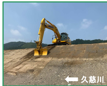
法面の整形を行っています
