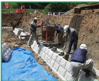
ブロック積を行っています
