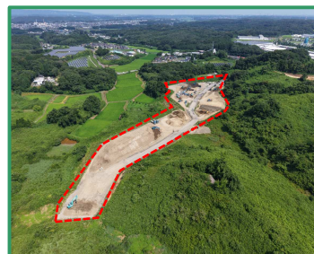
ストックヤードの全景（上流から）
