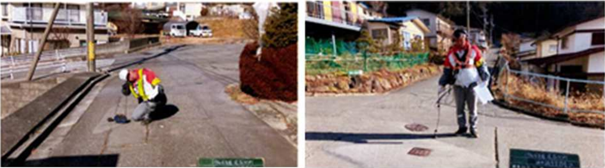
音調調査による点検の様子
