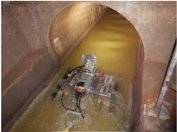
点検状況写真
