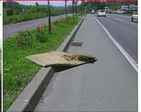
路面の落下物
