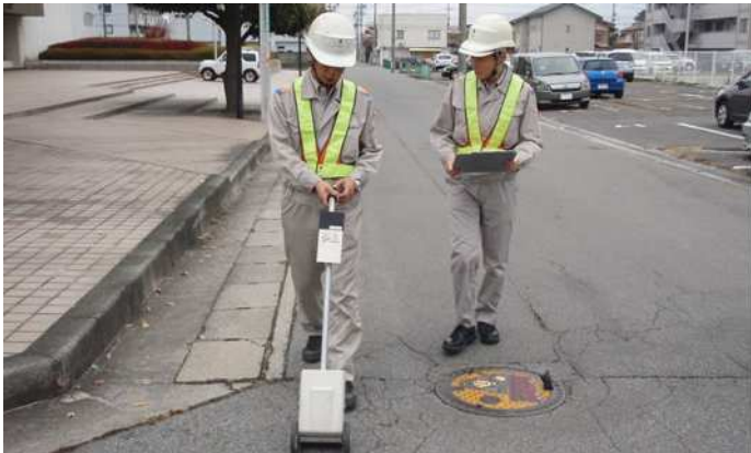
点検状況写真
