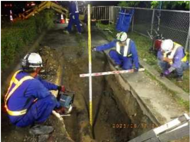
空洞箇所開削対応イメージ
