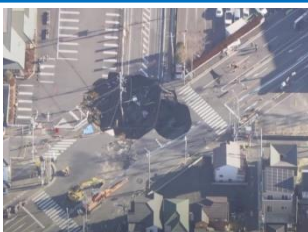
1月31日時点の事故現場の状況
