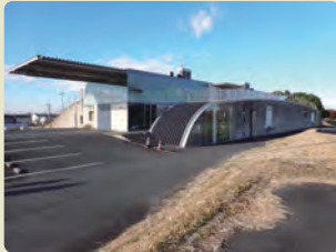
〈藤代地区河川防災ステーション〉
