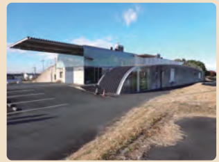
〈藤代地区河川防災ステーション〉
