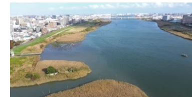
多摩川下流部(4.2kp付近)
