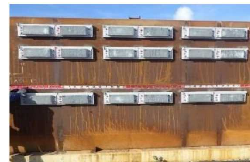
新素材試験片の岸壁への設置
