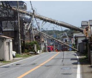
令和元年台風15号による電柱倒壊状況
