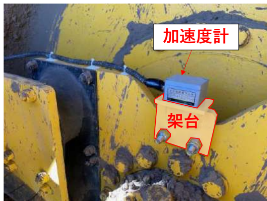
(a) 加速度計設置状況
