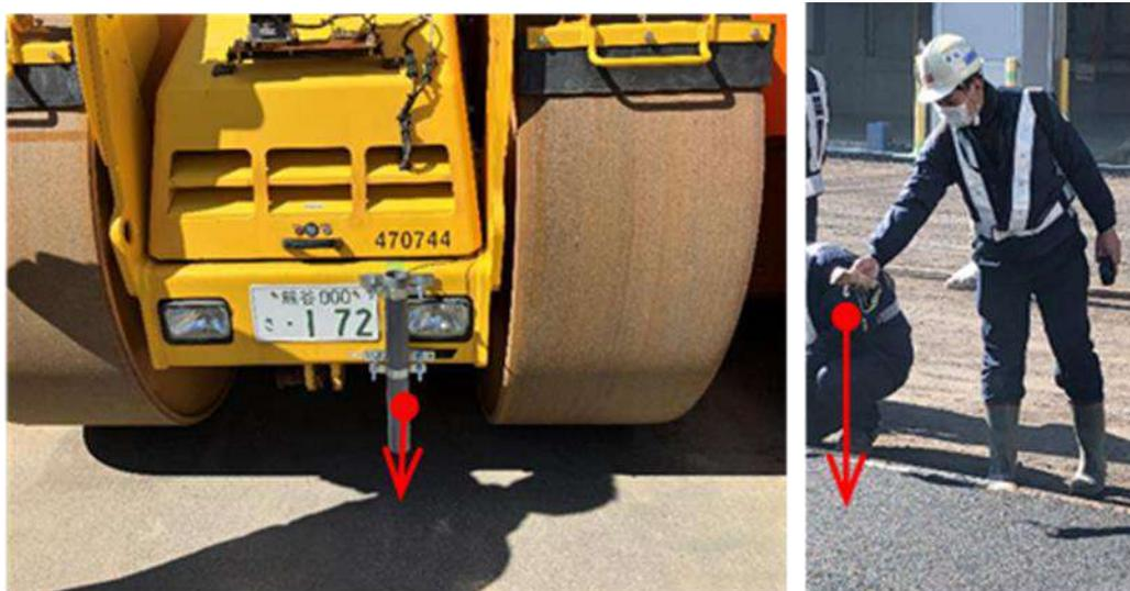
写真 2.1 計測温度精度確認 (例)
