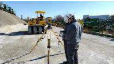
【写真3 自動追尾TSによる変形量の計測】
