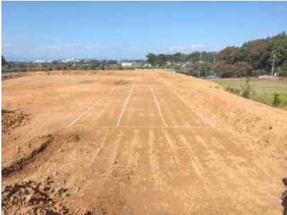
試験フィールド 3レーン×幅2.5m×延長25m
