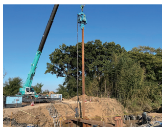
鋼矢板打設の様子
