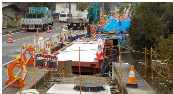
歩道橋施工状況
