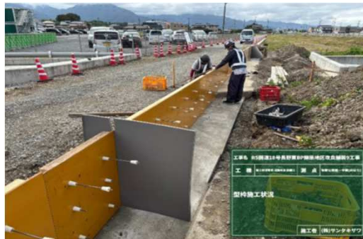
型枠組立状況
