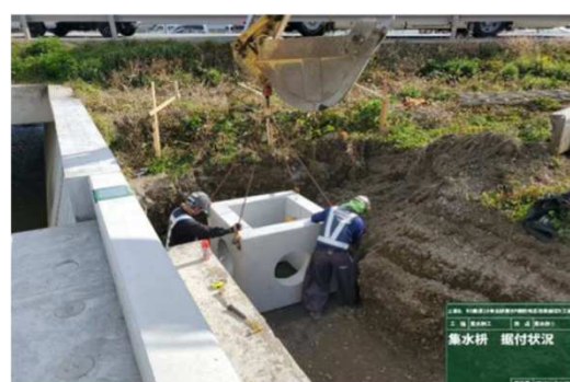
集水枡設置状況
