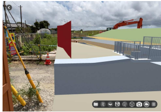
ARによる官民境界と構造物との離隔確認
