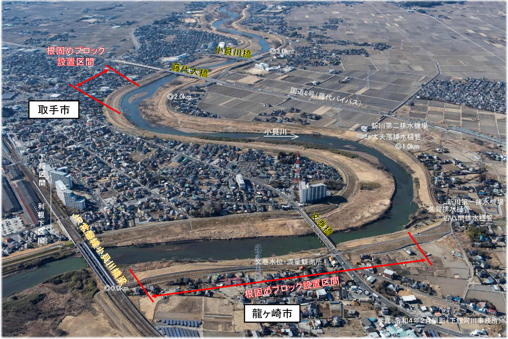
《参考2》水際に根固めブロックが設置されている他の箇所
