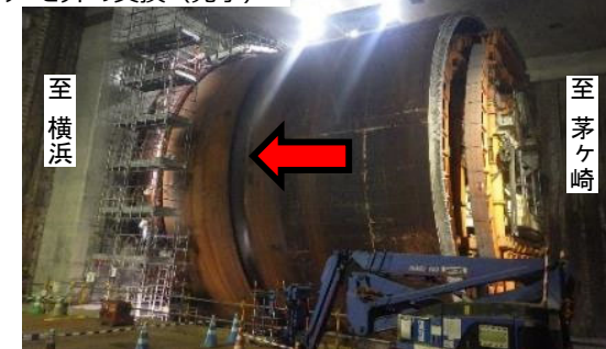
写真①：シールドマシンの前移動（完了）
