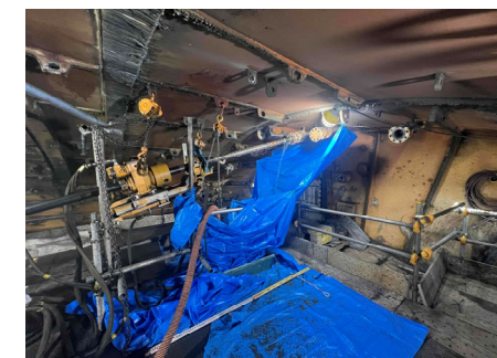
写真④：先受け鋼管の打設状況
